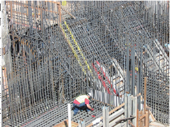
コンクリートを流し込む前の鉄筋
