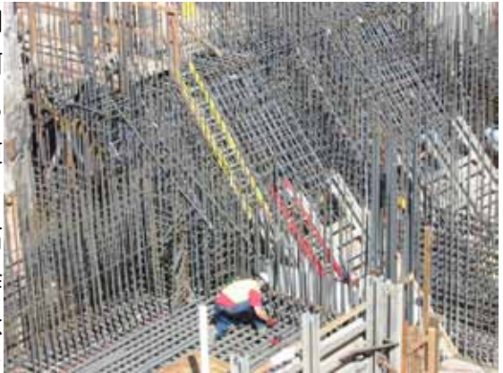
コンクリートを流し込む前の鉄筋
