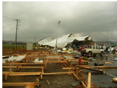
写真3 被災直後の新佐呂間トンネル作業事務所・宿舍 (国土交通省北海道開発局提供)
