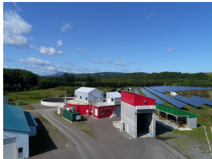
興部町バイオガスプラント
