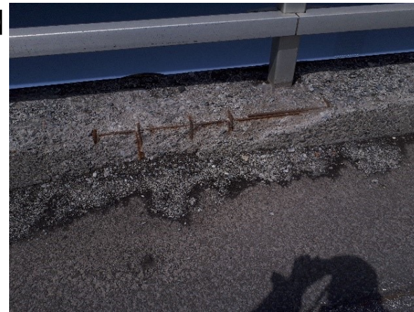
鉄筋腐食
