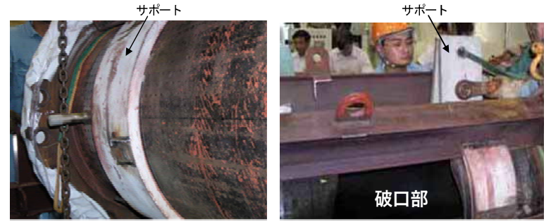
図 3. 1-1 サポート (白色部) の取り外し状況
