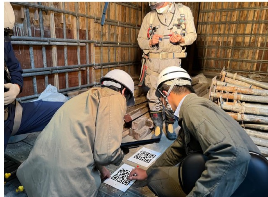
現場で基準座標値 (X,Y,Z) を QRコードにより認識
