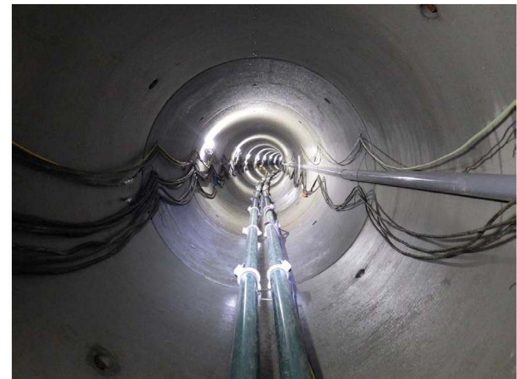
清田第2幹線耐震化工事（送水管）
