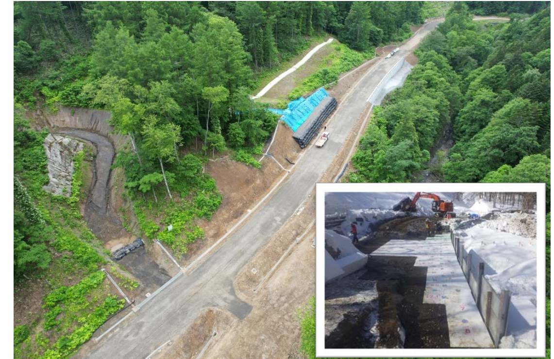
美唄富良野線 擁壁工事（美唄工区）
