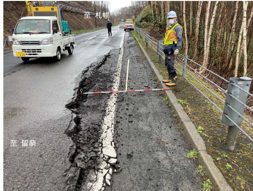
写真-2 路面の亀裂・段差状況（滑落崖5） （延長26m程度、最大段差30cm程度）
