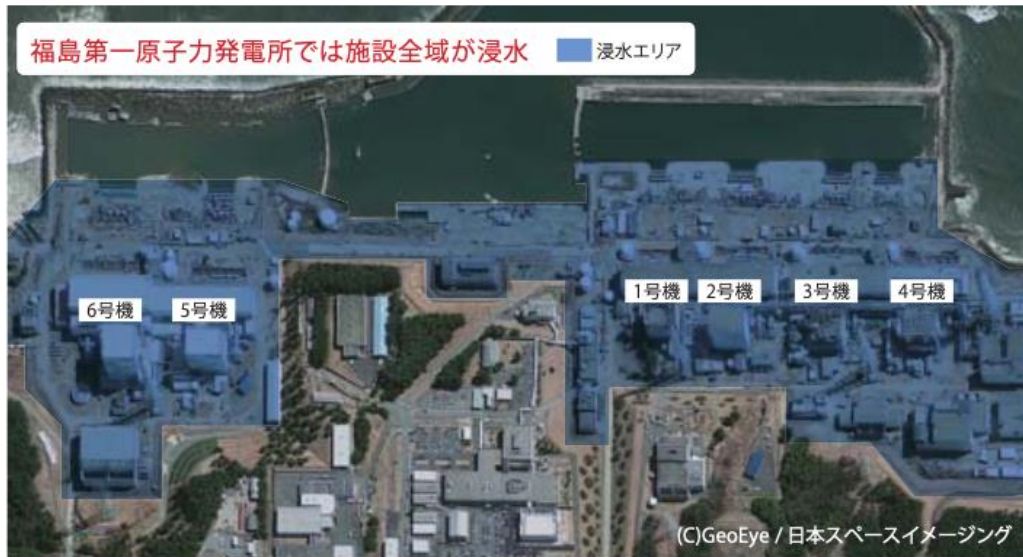
津波による被害を受けた後(全体)の福島第一原子力発電所 2011年3月19日撮影
