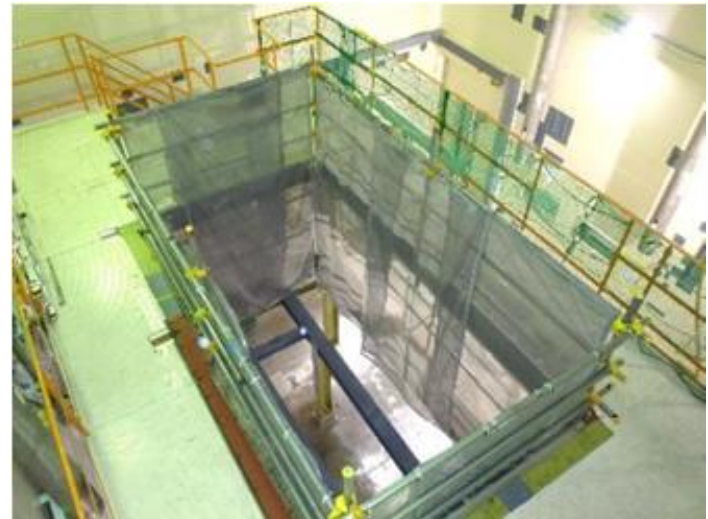
解体撤去された溶液系STACY [9]
